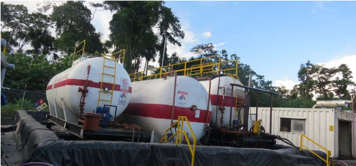
Colocación de membranas impermeables en el campo del proyecto
