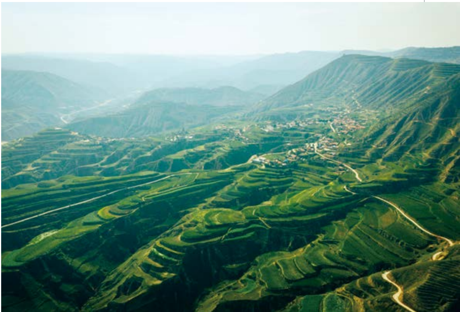
梯田整理后焕发勃勃生机。为助力改善生态环境，中国石化投入资金 200 万元，完成生态绿化工程项目，铺设管网 5000 米，开挖蓄水池 10 座，应用具有中国石化自主知识产权的保水剂和固结剂 4.5 吨
