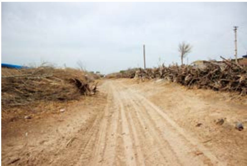
【东北石油局】原始道路
