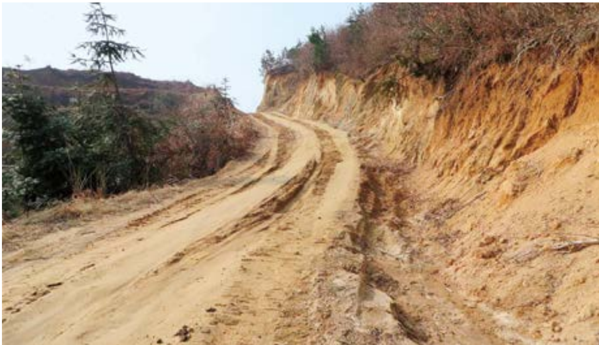
修建前的道路，泥泞不堪，坡度大、急弯多、路况复杂
