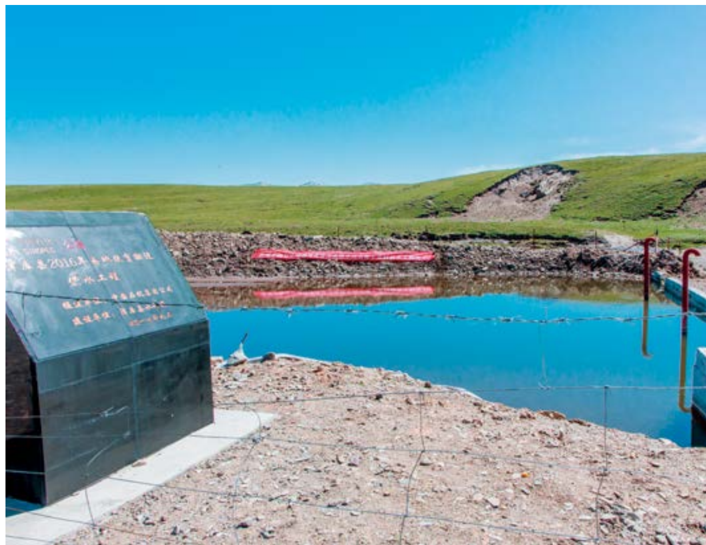
中国石化援建泽库县饮水工程
