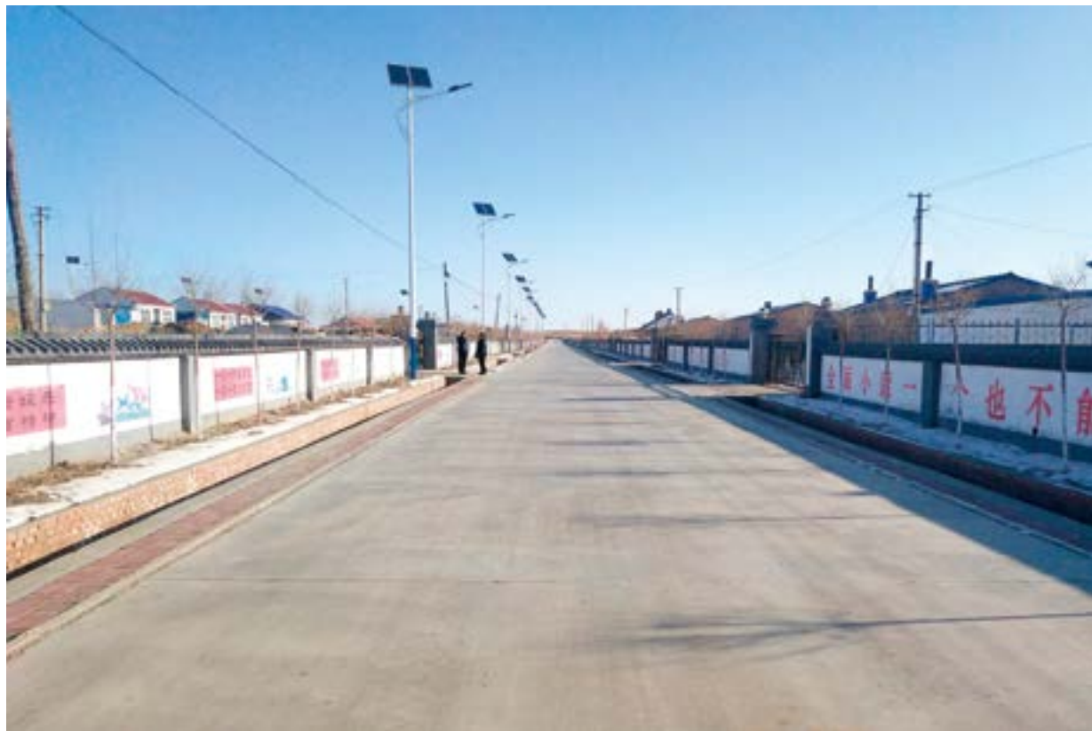
【东北石油局】整修后的道路
