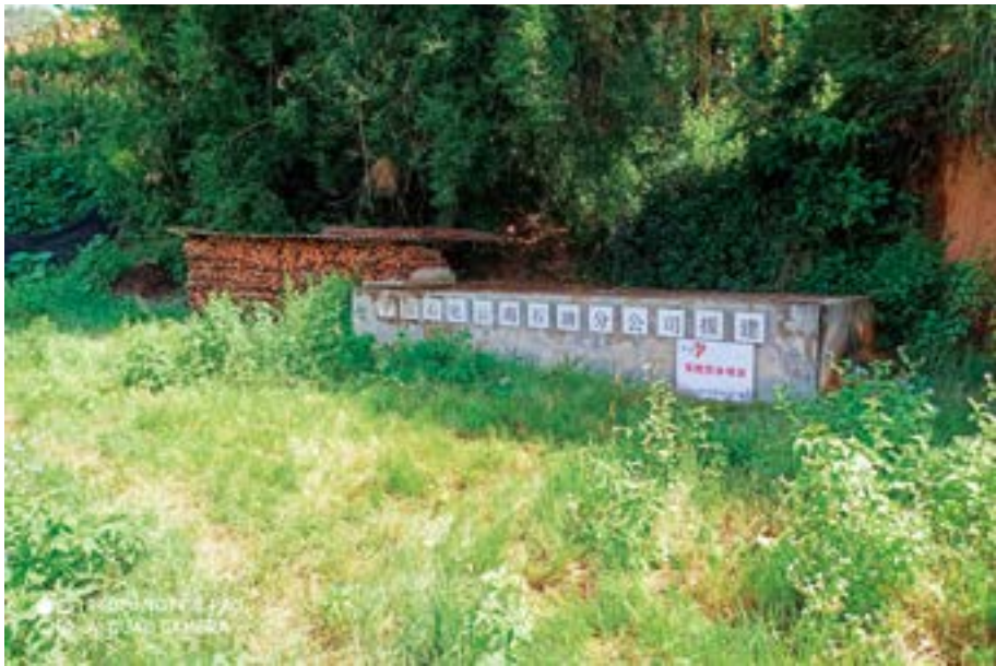
【云南石油】2018年4月投资5万元为云南省文山州砚山县蚌峨乡六掌村民委半坡建设蓄水池
