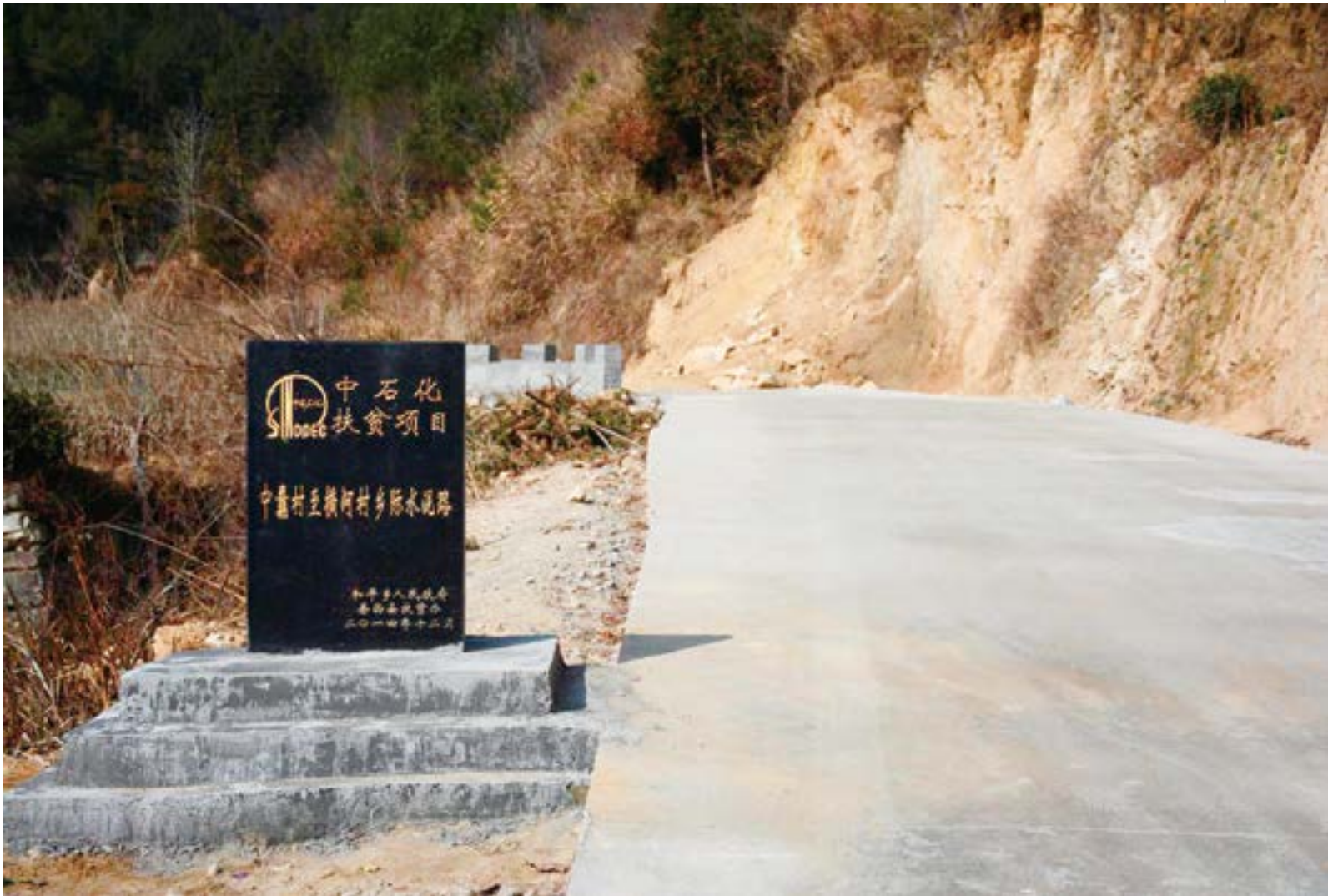
中国石化投入 274 万元修建道路，水泥路面总长度 10 千米，路修好了，为广大山区老百姓解决了“行路难”问题，为促进山区经济强有力的发展发挥了重要作用
