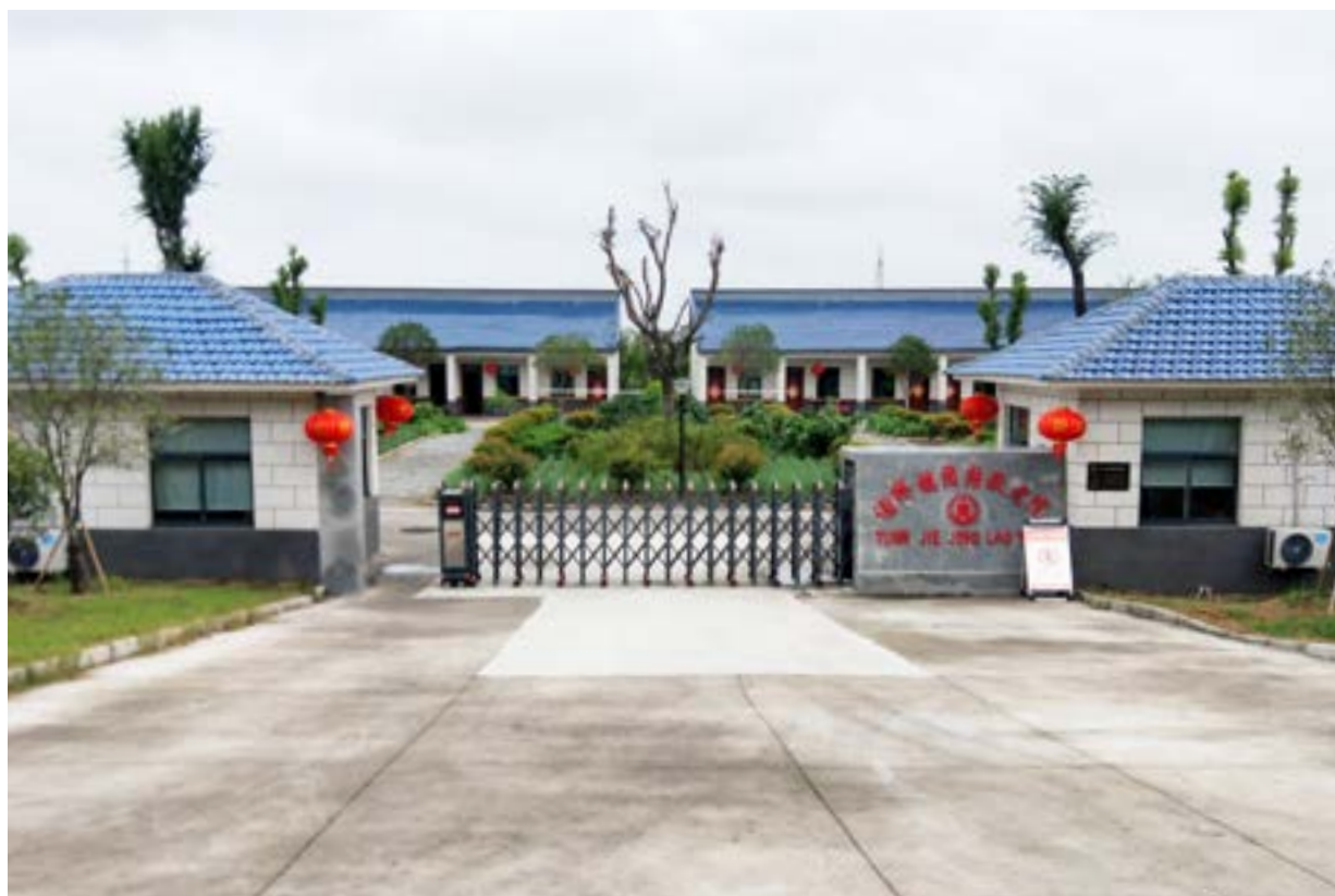
中国石化在颍上县建设的第二所敬老院——团结敬老院，位于团结村附近，可安置 58 位五保老人入住
