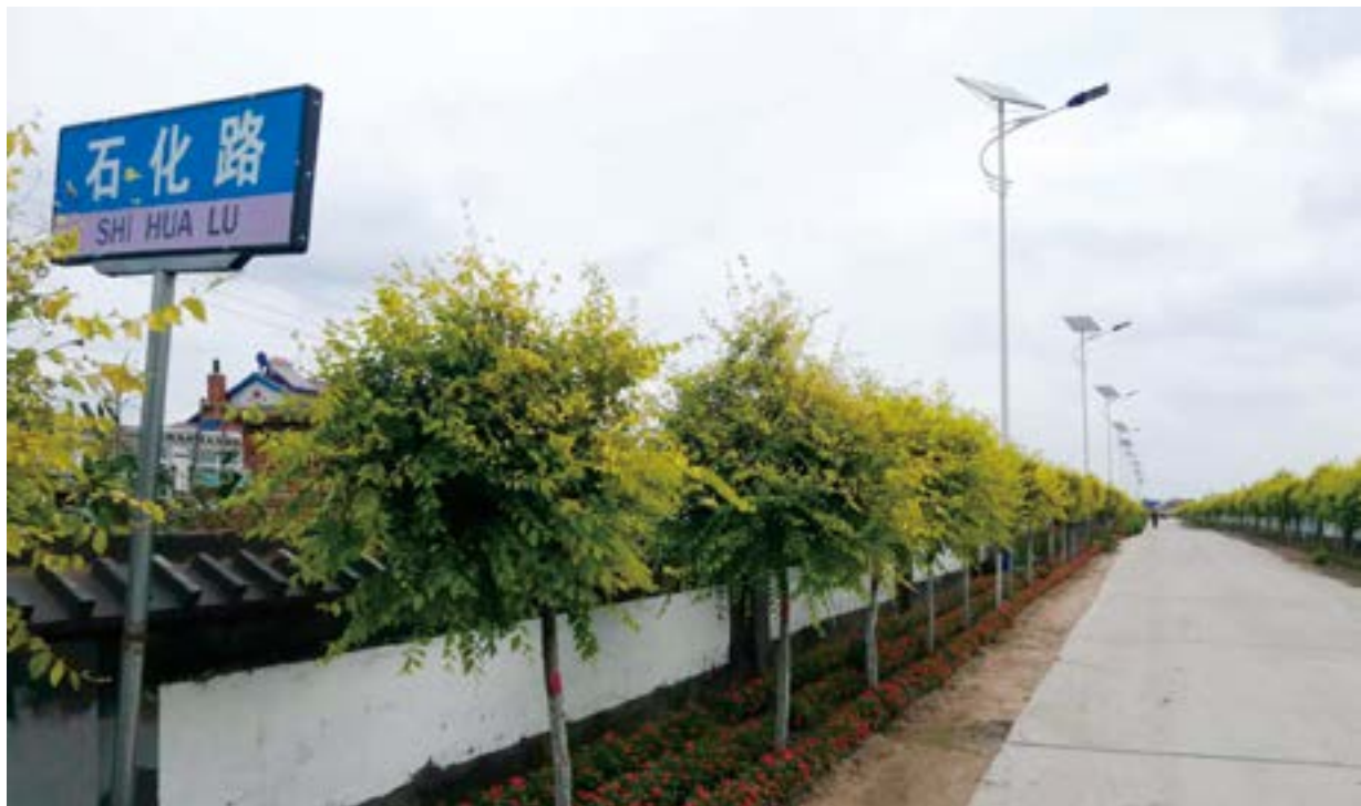
【东北石油局】整修后的围墙
