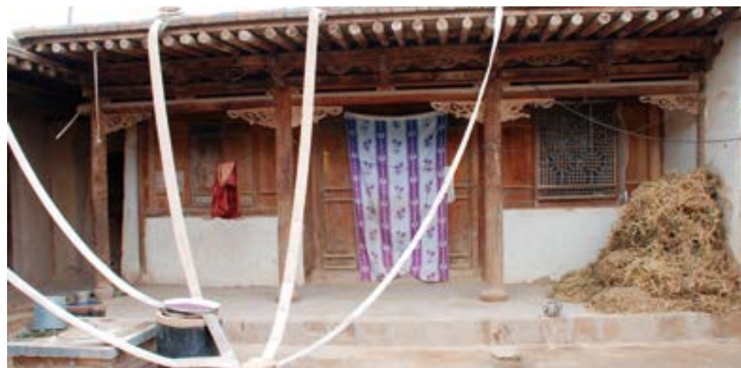
雨水贵如油，20 世纪七八十年代，干旱缺水的群众为解决人畜饮水问题，在下雨天将自家屋顶的雨水引流灌入水窖中，以备日常用
