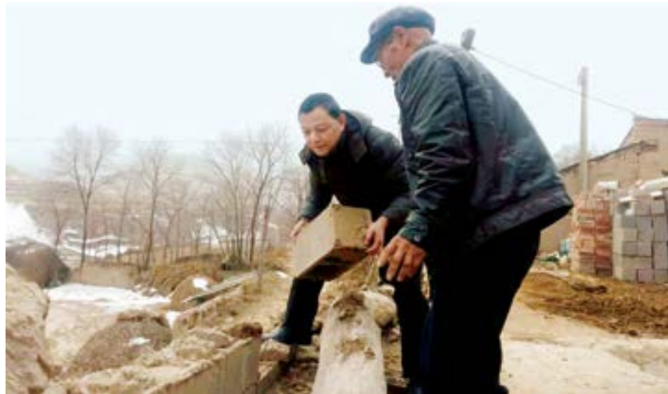
【宁夏石油】扶贫干部帮助贫困百姓修筑围墙
