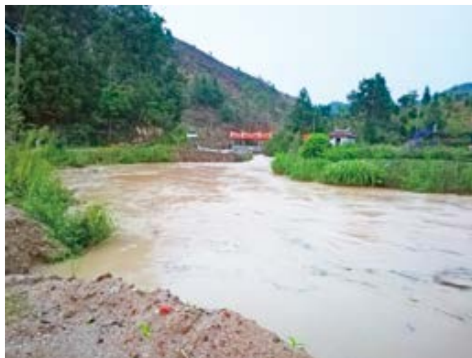
【福建炼化】整治前的河道。乌殊村作为蓝田水库的上游，曾经洪水泛滥
