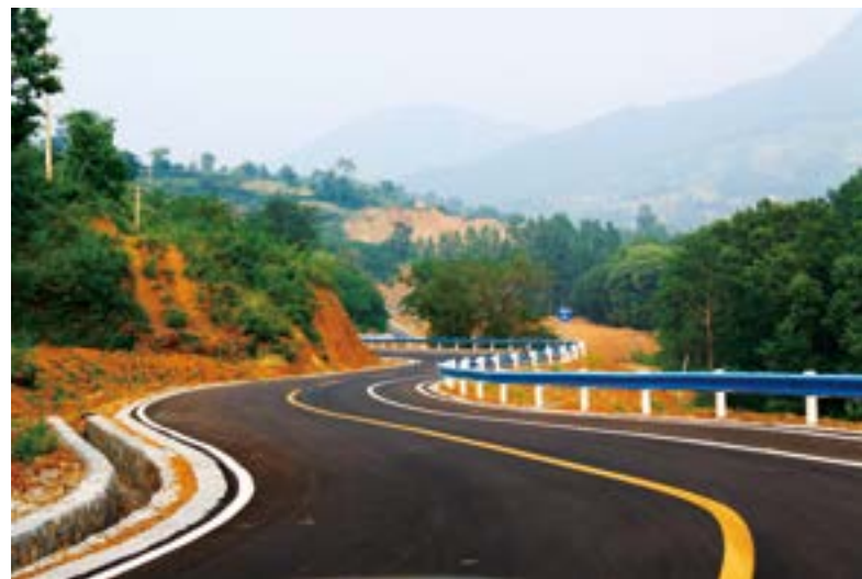
【洛阳石化】援建的通村道路
