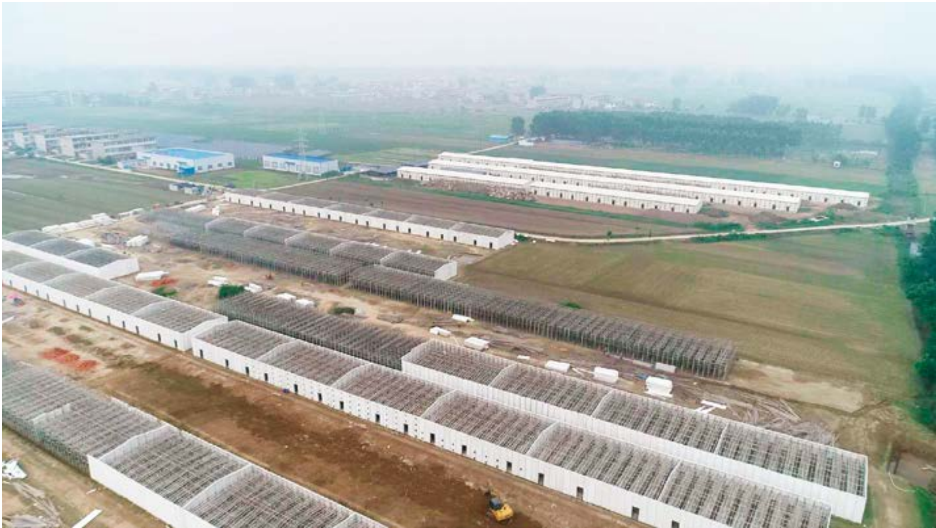
赛涧双孢菇生产基地二期建设全景
