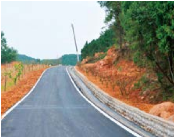
【西南石油局】整修后的三会村道路
