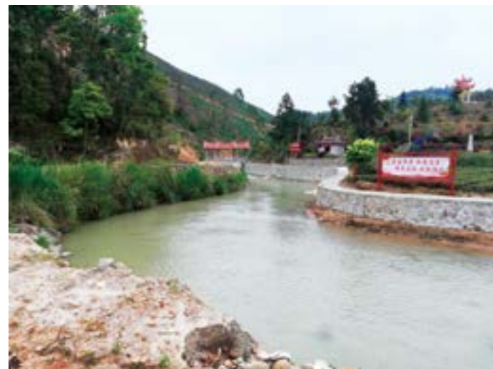
【福建炼化】整治后的河道。筑堤绿化，乌殊村旧貌换新颜
