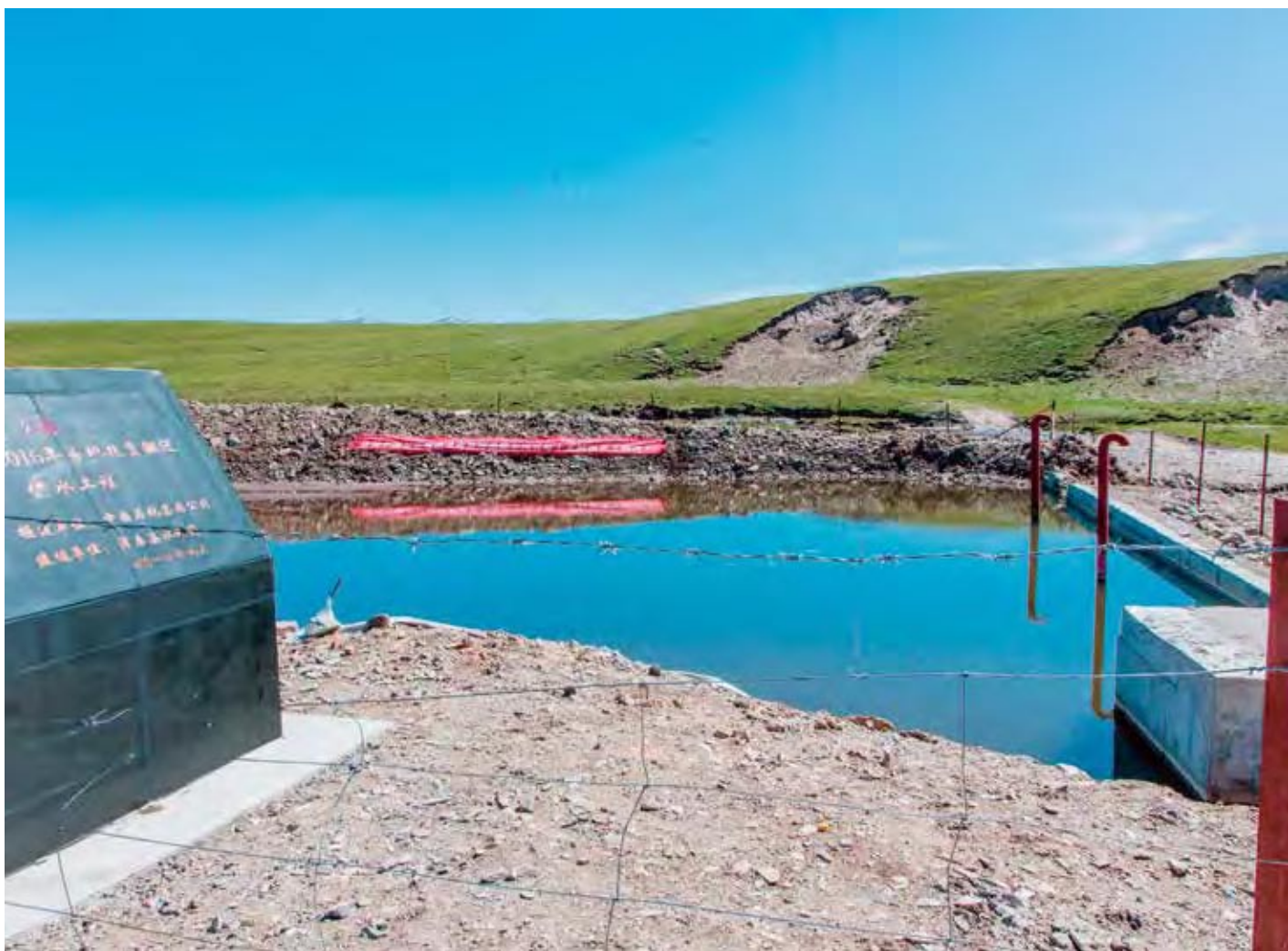
泽库县易地扶贫搬迁供水工程
