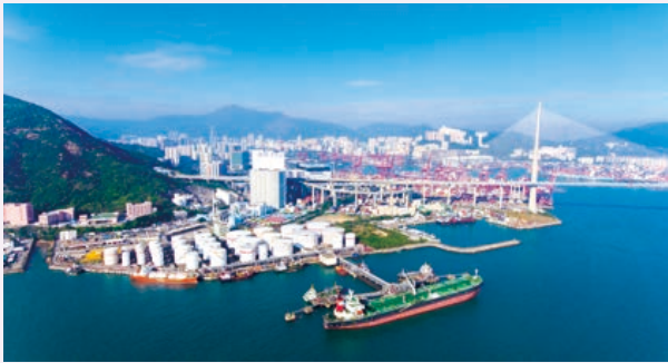
香港最大的单体油库——中石化香港公司青衣油库
