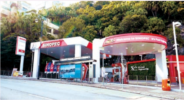
中石化香港公司山顶道加油站
