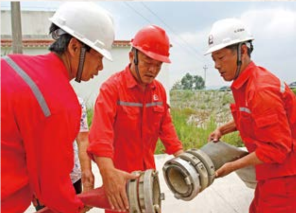
▲ 2017 年 3 月以来, 重庆涪陵地区天台片区的饮水水源王家湾水库接近枯竭, 中国石化江汉油田涪陵页岩气公司铺设管线, 将远处地下水输送至王家湾水库, 顺利解决天台片区及沿线的凉水村、七龙村等 11 个行政村 11,000 名民众的生活用水和农田灌溉。
