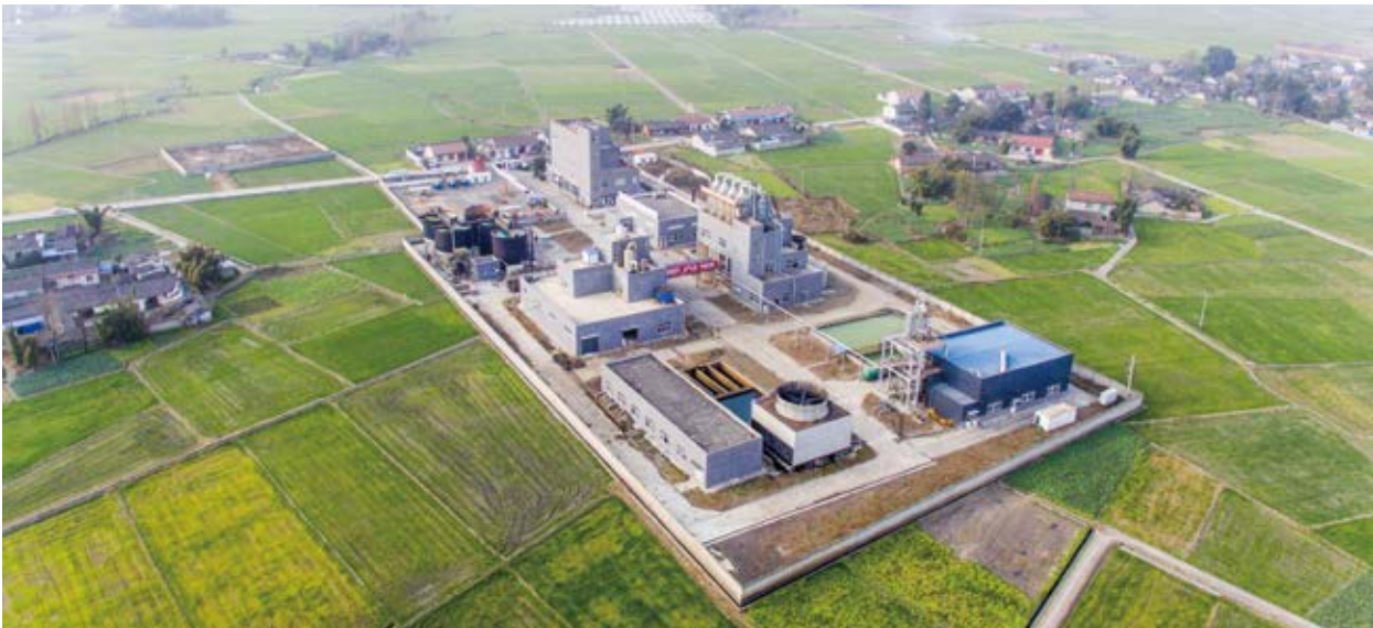
▼ 川西气田高氯根采气地层水处理站
