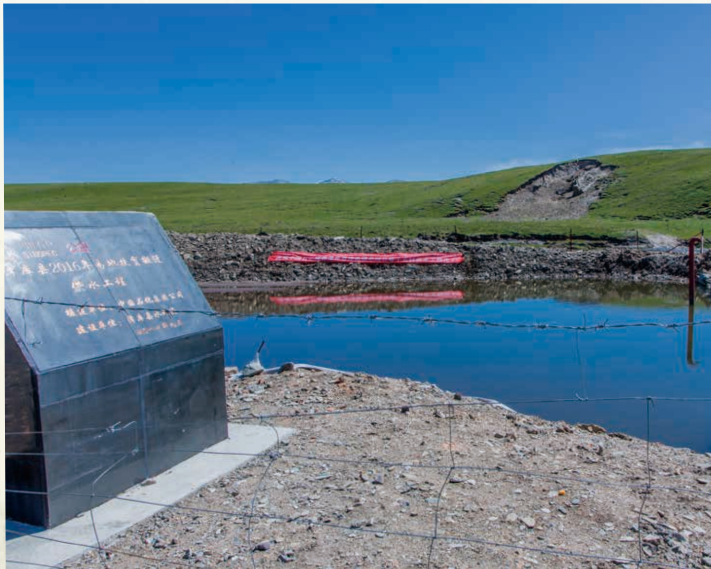
■ 泽库县易地扶贫搬迁供水工程
