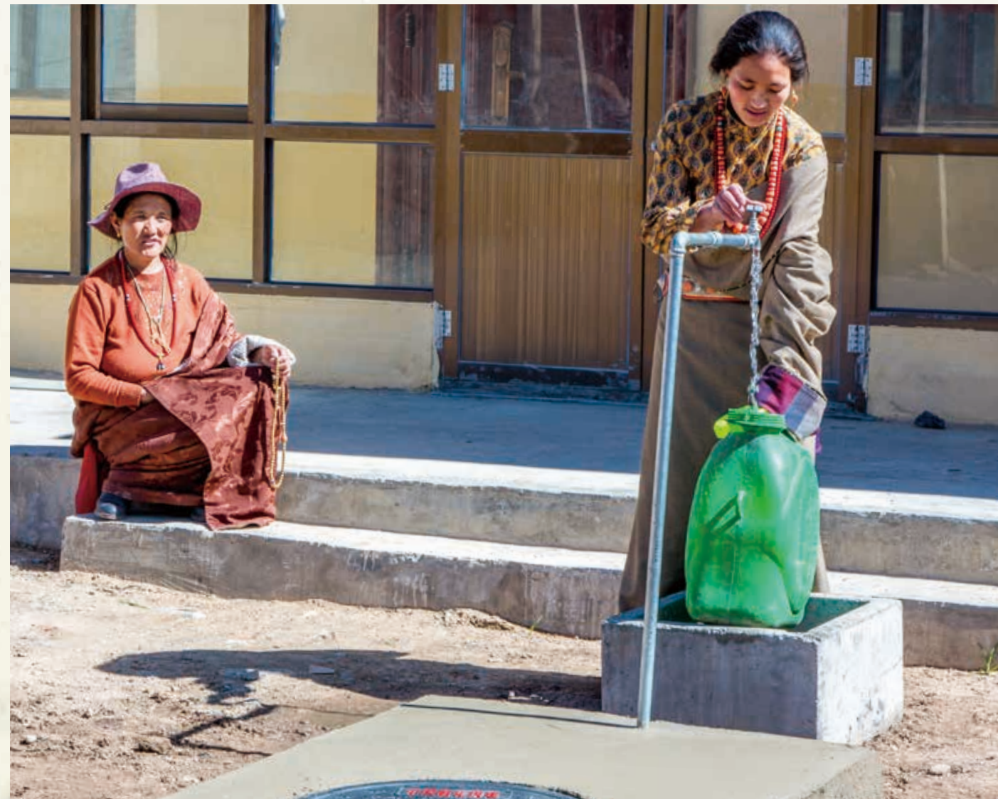
■ 泽库县易地扶贫搬迁供水工程
