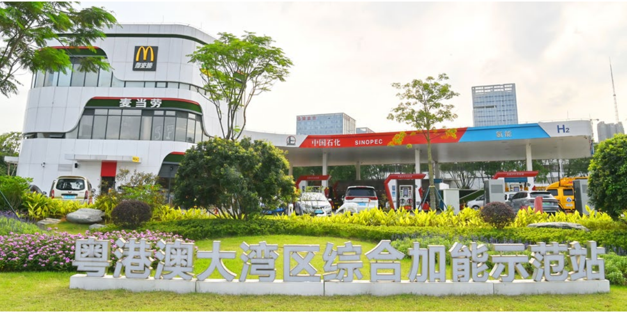
中国石化投营的大湾区首座综合能源服务站——广州东明三路综合加能站
