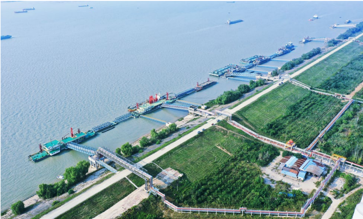
中国石化巴陵石化实施长江白尾码头提质改造项目，打造生态环保的现代化码头
