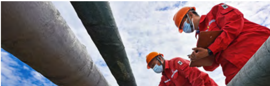
胜利油田河口采油厂员工对输油管线进行加密巡检
