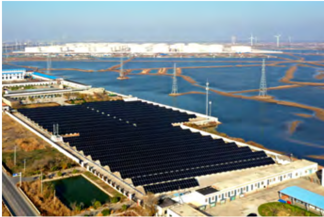
胜利海上油田最大光伏发电项目并网发电
