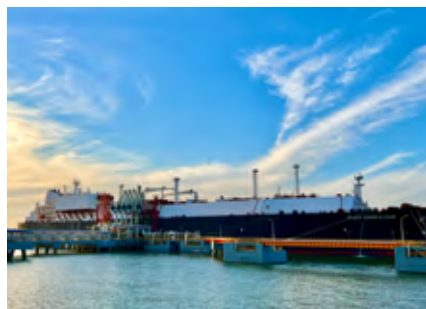
天津 LNG 接收站
